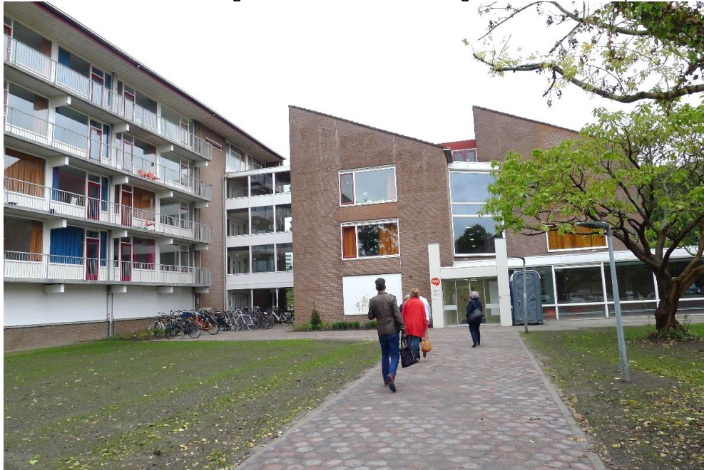
Foto 6 Gerenoveerd woonzorgcentrum: Studentenhuisvesting De Zeven Provinciën, Voorschoten
